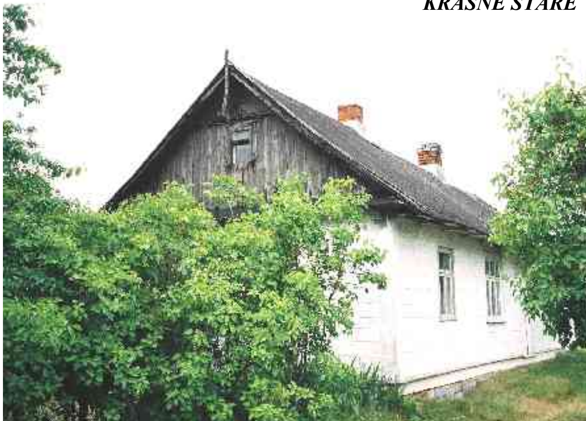
Drewniany budynek o konstrukcji słupowej, bez numeru, ustawiony szczytem do drogi, położony w bezpośrednim sąsiedztwie szkoły (od północy).
