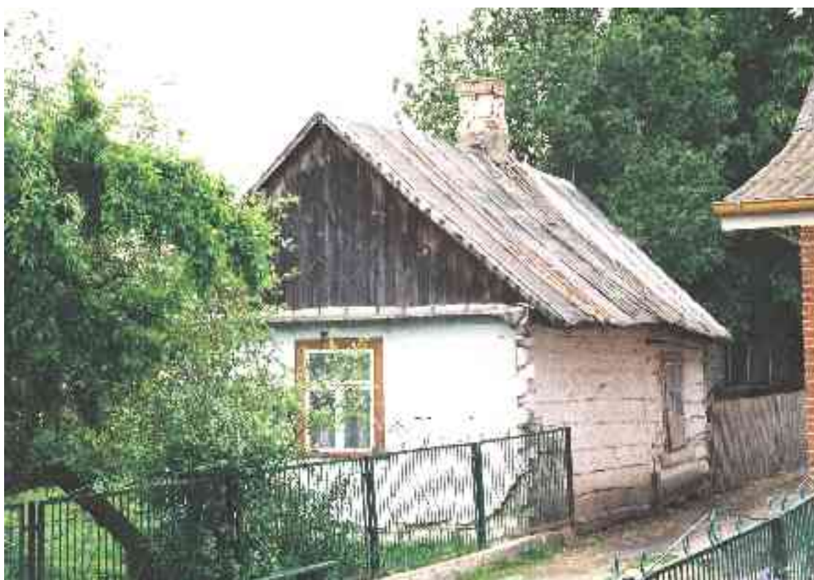
Domy drewniane o konstrukcji zrębowej (wiązanie na jaskółczy ogon).
