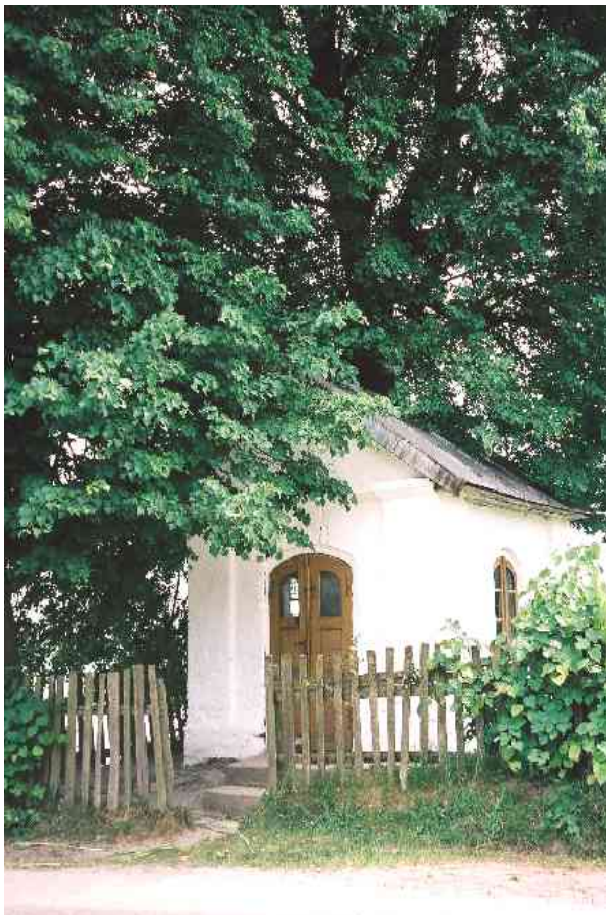
Głębokie – kapliczka murowana z 1905 r. (nr ew. 12094).
