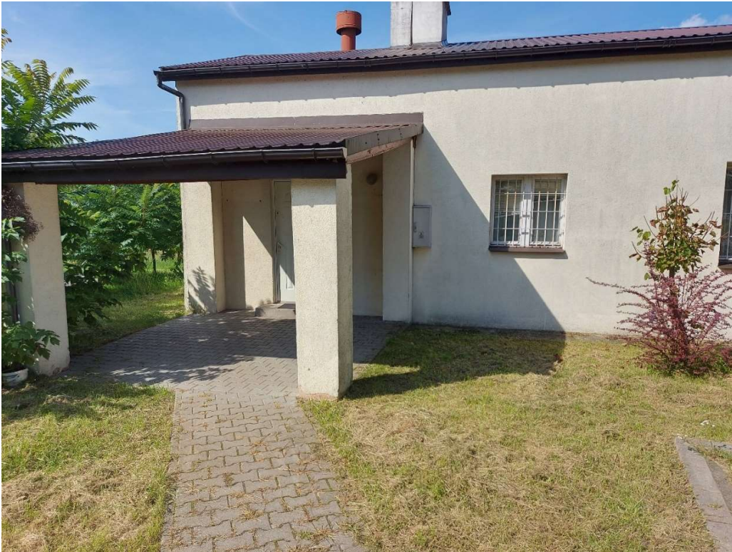
Fot. Budynek Opieki Społecznej znajdujący się w miejscowości Stary Uścimów
